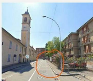
Fermata dei bus sostitutivi a Vanzago, via Garibaldi n°2
